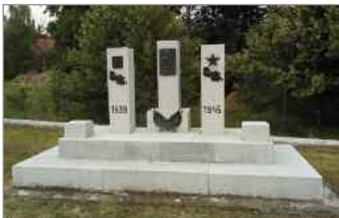
Čištění a oprava pomníků v celé obci
