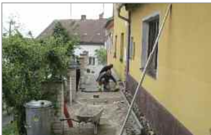
Oprava budovy pošty
