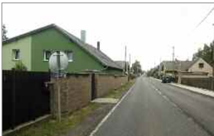
Oprava komunikace 1/18 - investor ŘSD
