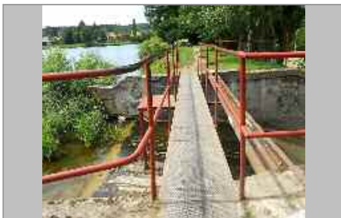
Oprava Vysokopeckého rybníka - investor Svazek obcí pro vodovody a kanalizace Příbram
