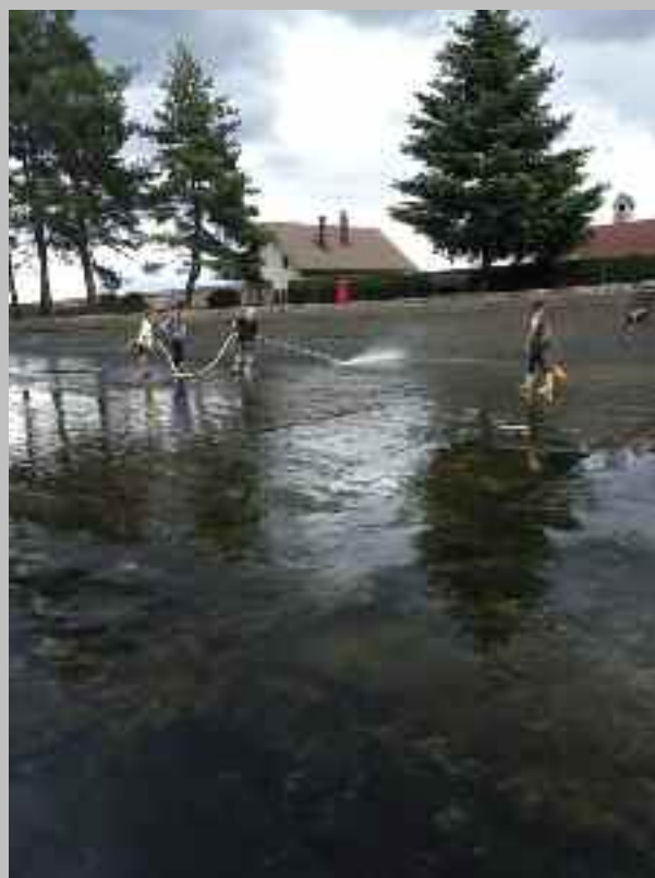
Čištění protipožární nádrže
