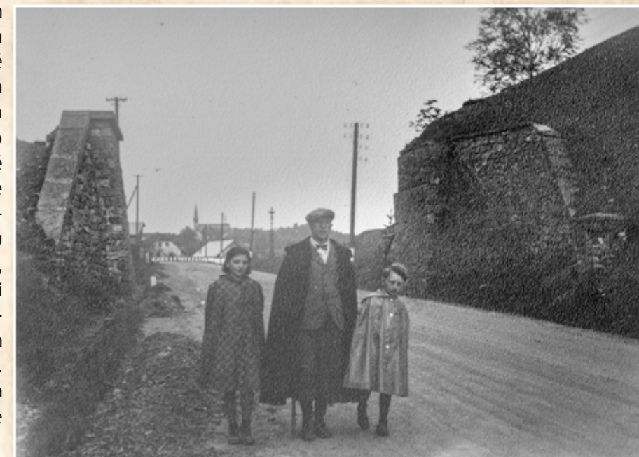
Na fotografii jsou zachyceny opěrné zdi přemostění pod sokolovnou. Po mostě se dopravovala hlusina z úpravy na přilehlé odvaly. Jak vypadalo přemostění v době své největší slávy je možné si prohlédnout na ilustraci Karla Hojdena ve sbírce povídek Havíři od Františka Zpěváka
