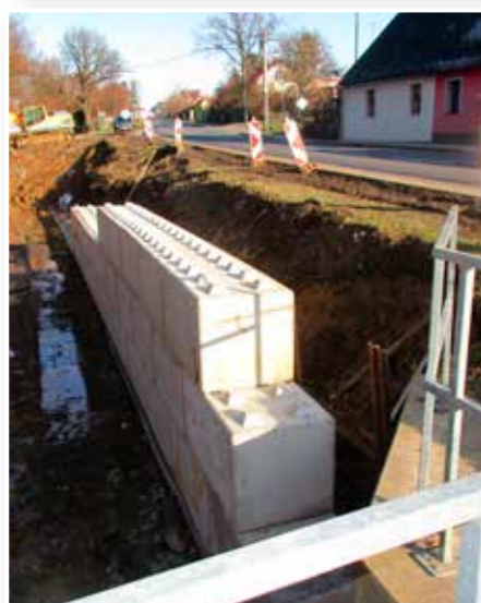
Oprava havarijního stavu opěrné zdi u silnice I/18 a stavidel Vysokopectkého rybníka. Investor: Svazek pro vodovody a kanalizace Příbram
