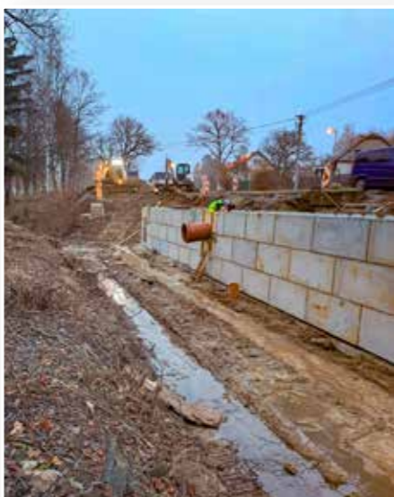
Oprava havarijního stavu opěrné zdi u silnice I/18 a stavidel Vysokopectkého rybníka. Investor: Svazek pro vodovody a kanalizace Příbram
