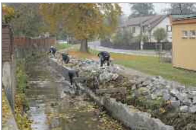
Rekonstrukce opěrných zdí u vodotečí.
