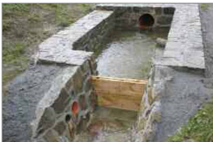
Rekonstrukce opěrných zdí u vodotečí.
