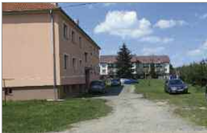
Budoucí parkovací plocha u bytoven v Bohutíně
