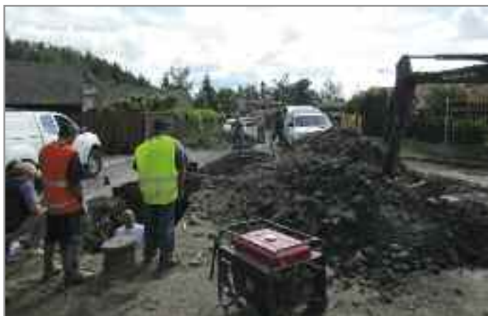
Informativní schůzka z vlastníky přilehlých nemovitostí a realizace opravy vodovodního řádu v západní části Bohutína. Výměna nevyhovujícího azbestocementového potrubí. Získaná dotace na výše uvedenou stavbu 250 tis.
