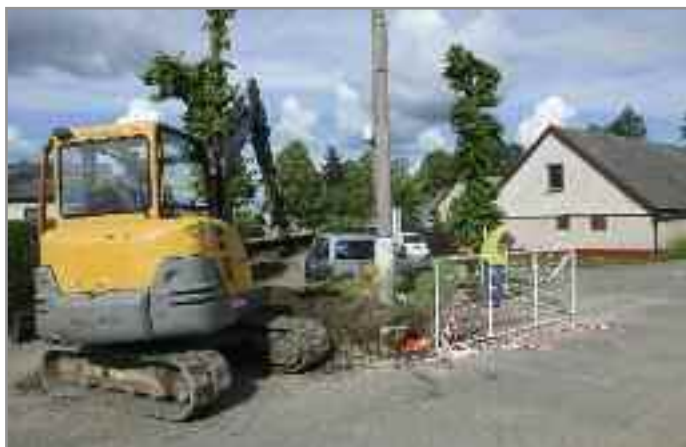
Informativní schůzka z vlastníky přilehlých nemovitostí a realizace opravy vodovodního řádu v západní části Bohutína. Výměna nevyhovujícího azbestocementového potrubí. Získaná dotace na výše uvedenou stavbu 250 tis.
