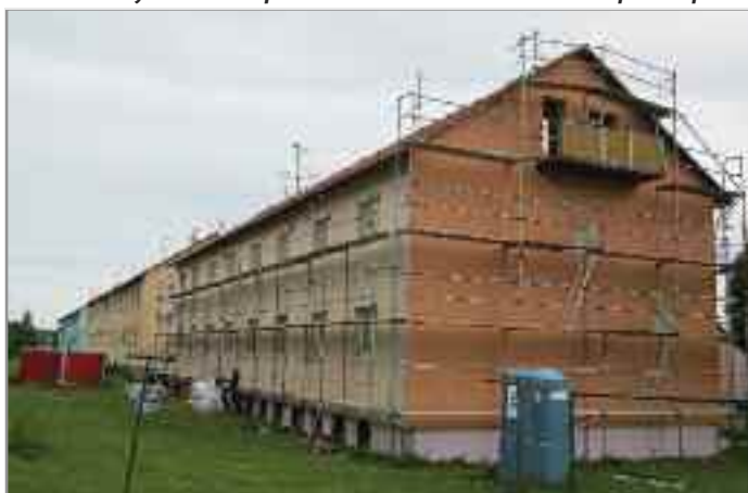
Rekonstrukce bytového domu na Vysoké Peci - sídliště.
