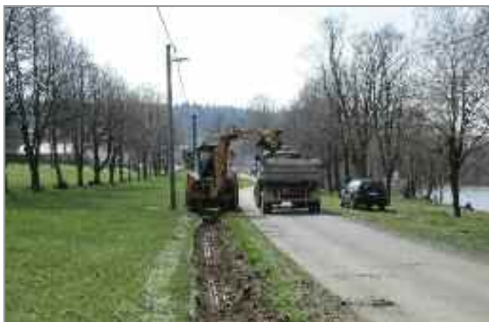
Čištění příkopu dešťové kanalizace u Vysokopeckého rybníka.
