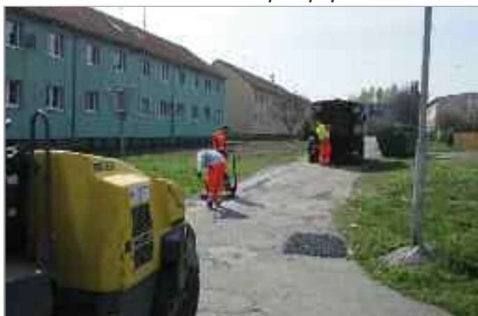
Výsrava baleným asfaltem na místních komunikacích.
