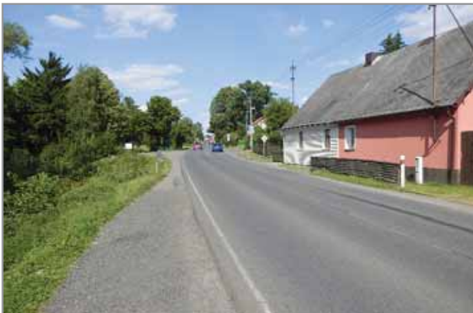
předpokládaná výstavba chodníku podél silnice I/18 - první etapa
