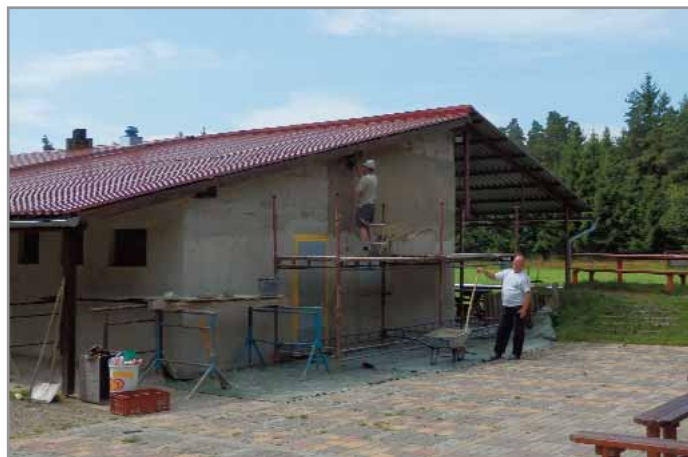
modernizace budovy kabin - SK Litavan Bohutín - r. 2014
